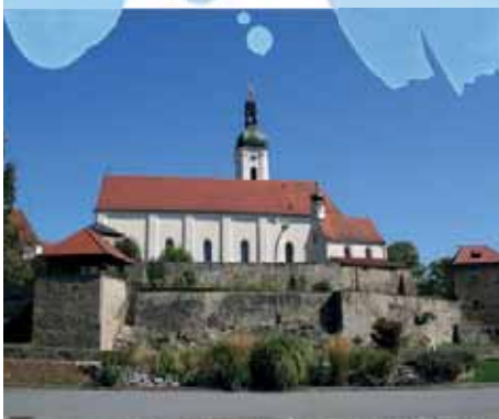
Stadtpfarrkirche Bad Kötzing
